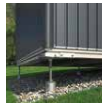
Nastavení výšky pomocí zemních šroubů
